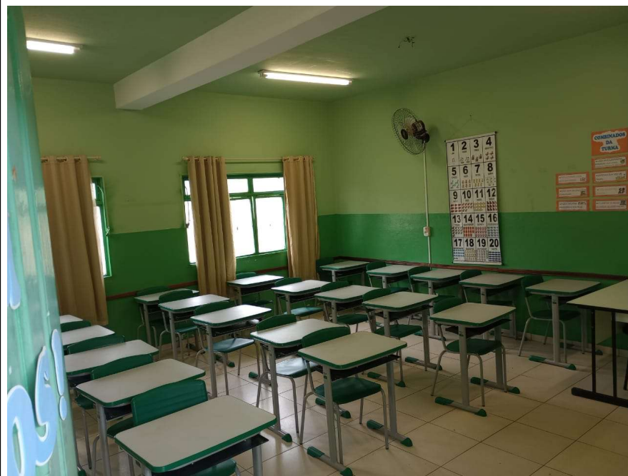
Descrição: SALA DE AULA, PARA REFORMA, FOTO TIRADA NO DIA 21-11-2022
