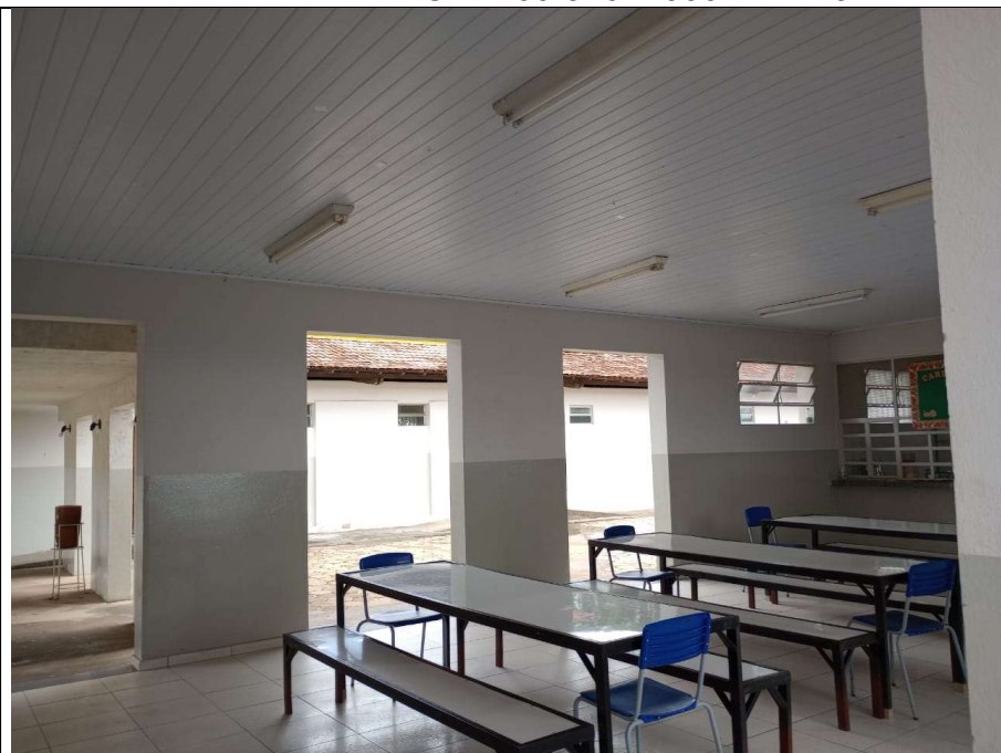
Descrição: REFEITÓRIO PARA REFORMA, FOTO TIRADA NO DIA 21-11-2022
